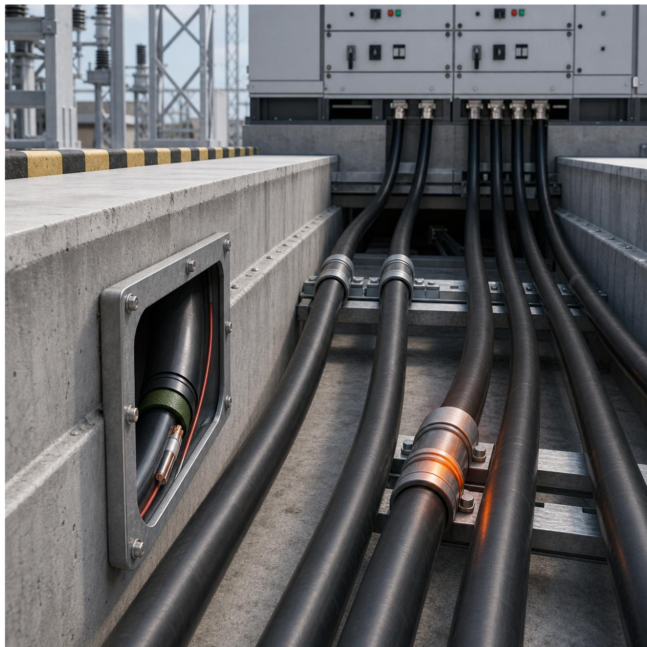
变配电站 / 电缆沟
